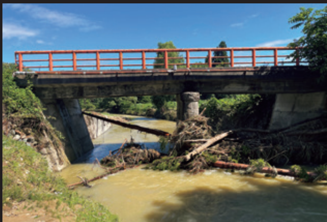
流木が溜まった左草15号橋
