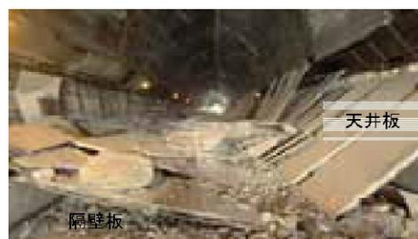
写真-4 天井板崩落状況②
