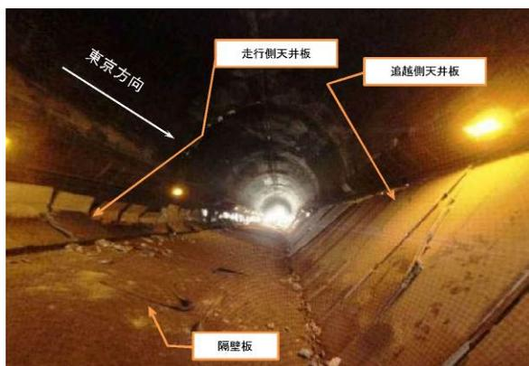
写真-3 天井板崩落状況①
