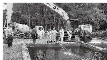
水源から引いた水を砂利層を通過させて浄化する中部浄水場
