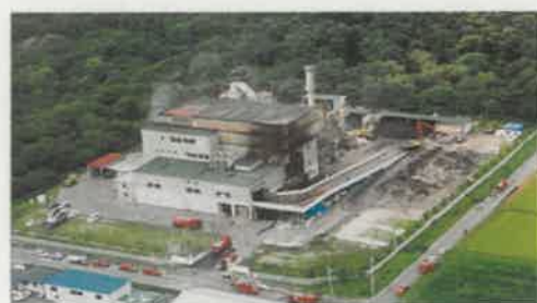
2006年9月和賀町産廃処理施設火災
