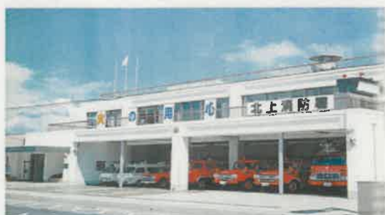
1977年3月消防本部・署庁舎新築落成
