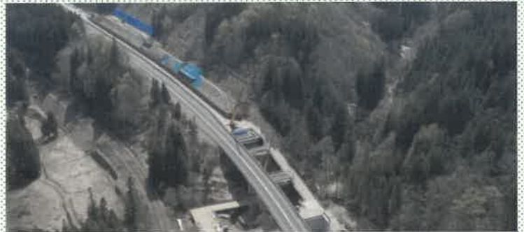
田代沢橋の施工状況
