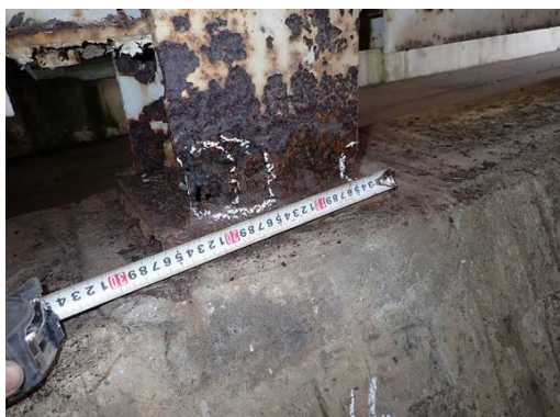
主梁基部の孔食を伴う腐食
