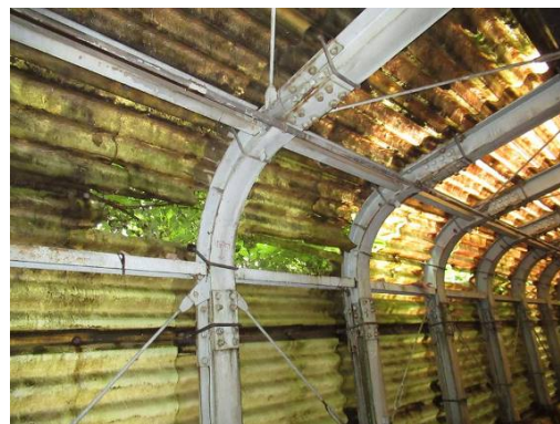
屋根材の変色、欠損(歩道部)
