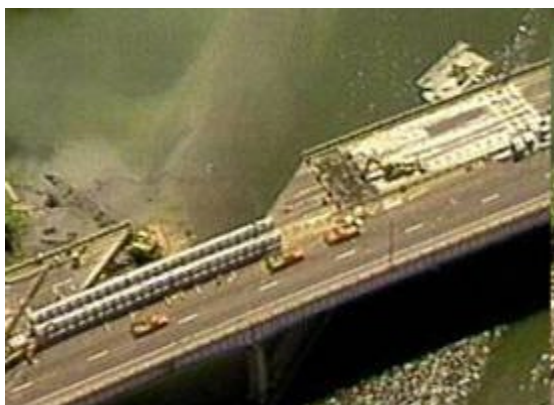
写真-1 マイアナス橋の落橋
