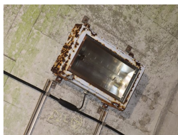
照明器具の腐食
