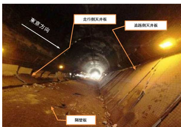
写真-3 天井板崩落状況
