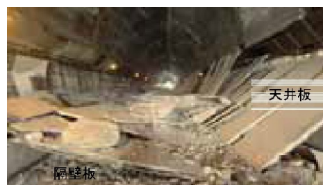
写真-4 天井板崩落状況②
