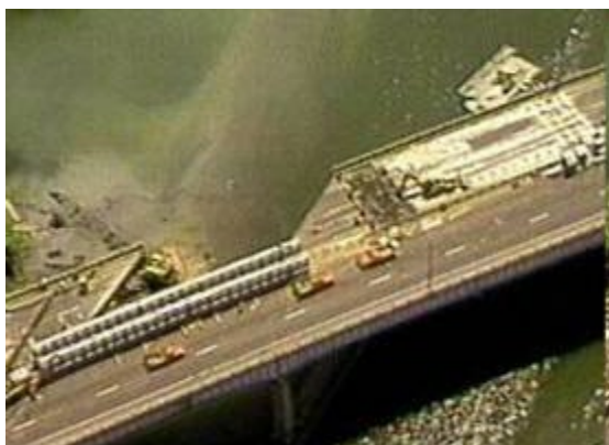
写真-1 マイアナス橋の落橋
