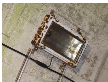
照明器具の腐食
