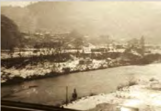
▲水没直前の一跳地区、大黒線（現在の北上線）。 水没のため、上に移動させた。
