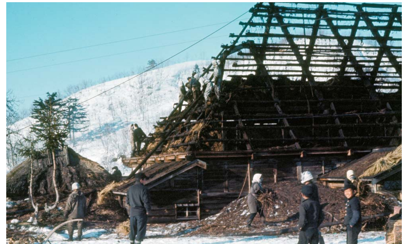
野々宿の菅原信夫さんの家を、地域総出で解体している様子で、昭和36年頃の写真です。高橋文夫さん（92）が若かりし頃撮影していた写真がネガの状態でのこっていたため、現像したものです。
