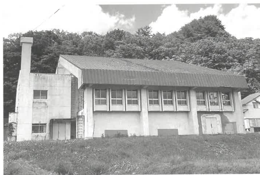
解体が決まった川尻体育館
