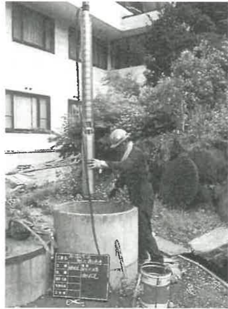
同型ポンプの設置風景
