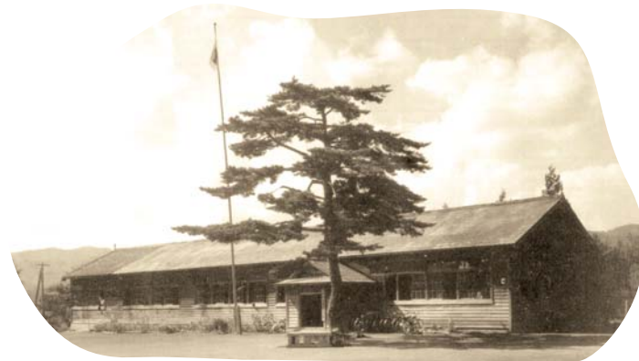
旧長瀬野小学校校舎
