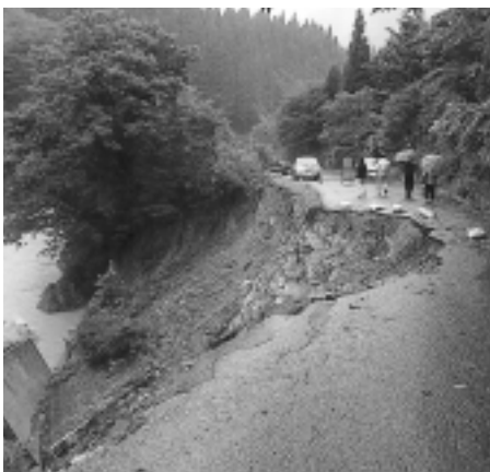
今年8月には復旧予定の丸子峠線
