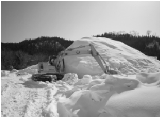
雪山の造成作業の様子
