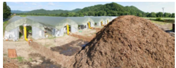
写真 6 イチゴハウスの雪冷房
