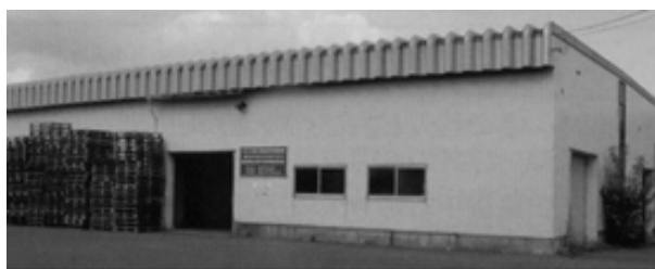
写真1 農産物集出荷予冷貯蔵施設
