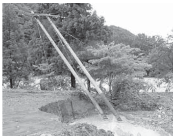
弁天島付近の水田が陥没し 電柱が倒れる
