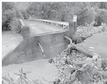
若畑橋の橋台が掘られて 水道送水管が断裂
