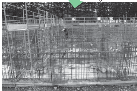
【3工区】基礎工事を終え、各種配管が通る地下部分から1階への立上り鉄筋工事が進められています。
