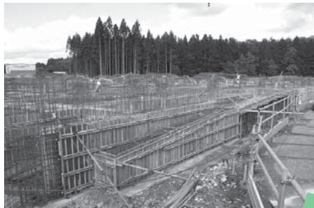
【2工区】基礎工事を終え、1階床工事が進められています。外に通じるスロープ工事も行なわれています。
