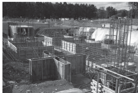
【機械棟】基礎工事が進められています。掘削を進めていくと水が湧き、汲み出しながら作業を行っています。
