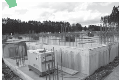
【1工区】1階床コンクリート工事を終え、上階への立上り鉄筋工事が始まります
