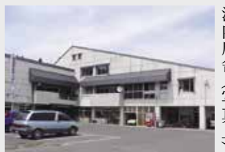
沢内庁舎（写真上）と湯田庁舎
